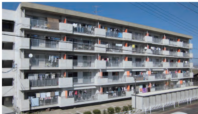
宝江住宅耐震改修工事(一宮市)
