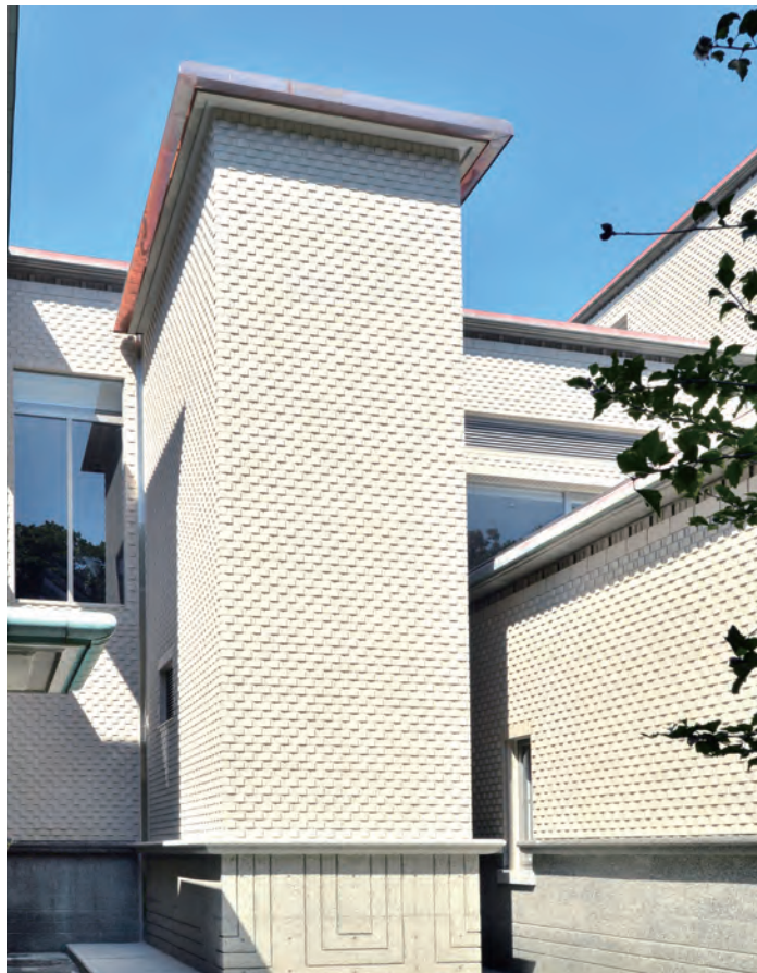
一宮市博物館エレベーター棟増築工事
