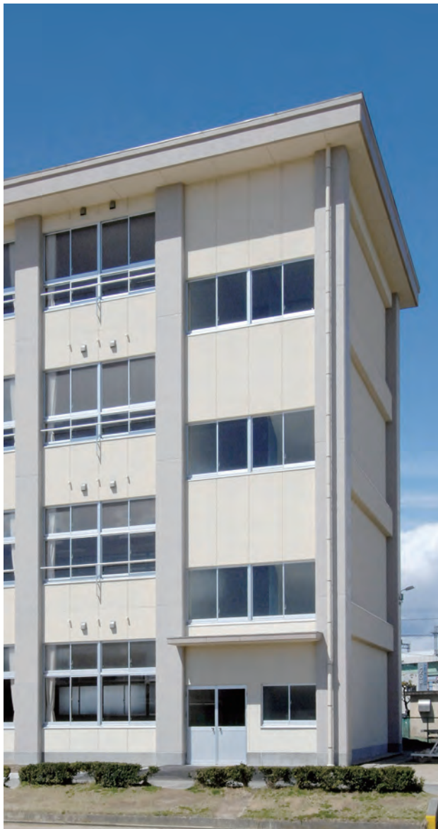
丹陽南小学校校舎増築工事(一宮市)
