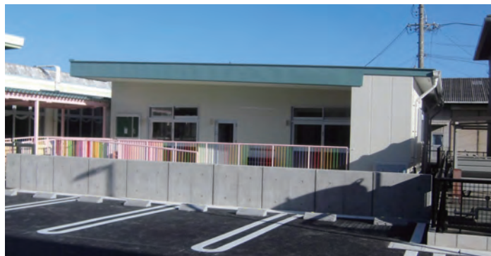
箆屋保育園乳児室増築工事(一宮市)
