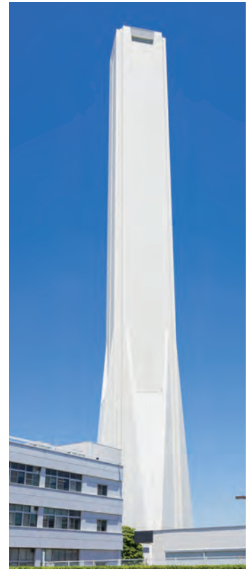
三菱電機エレベーター試験棟
