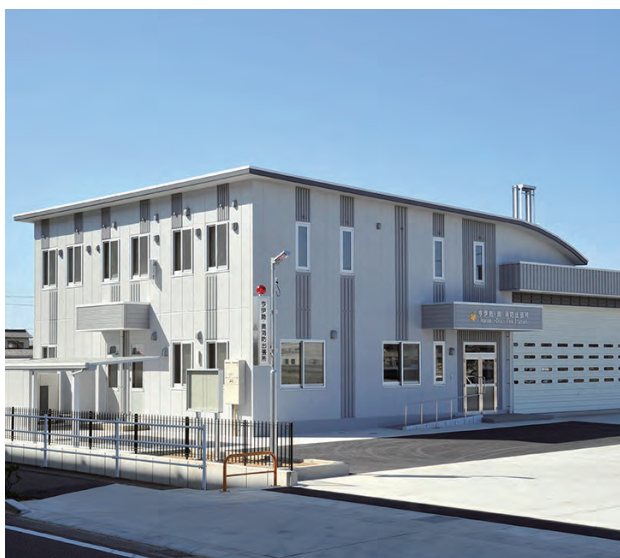
今伊勢・奥消防出張所建設工事(一宮市)
